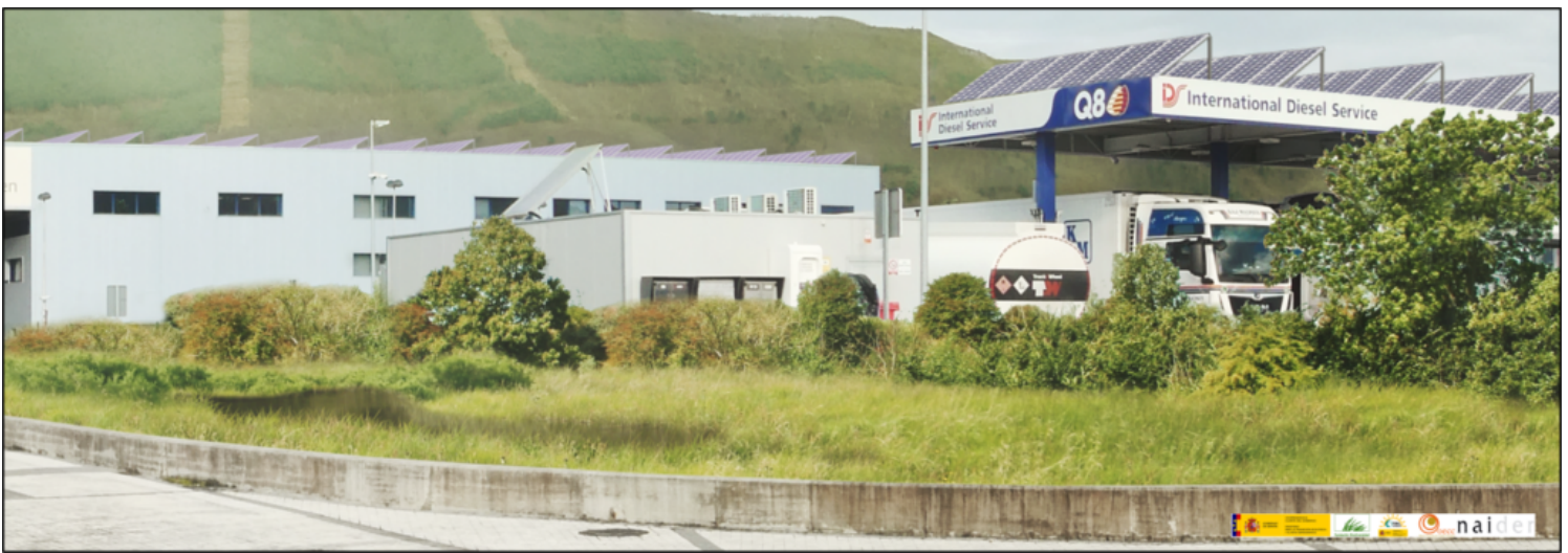
Polígono industrial de Araso (Irun) con cubiertas solares para el auto-abastecimiento con energía limpia y jardines de retención de agua de lluvia para prevenir inundaciones
